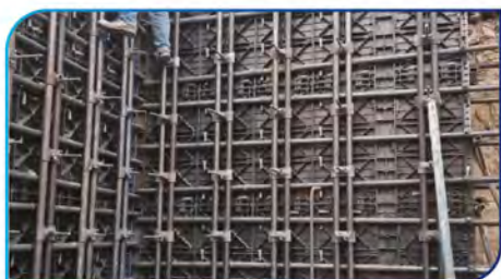
عدم خم شدگی قالب تحت فشار زیاد بتن
