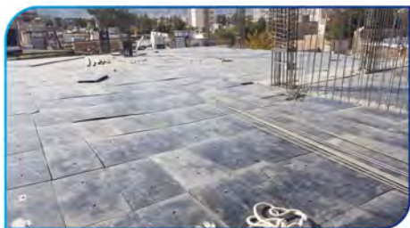
جایگزین ورق پلاستی وود برای زیر سازی دال
